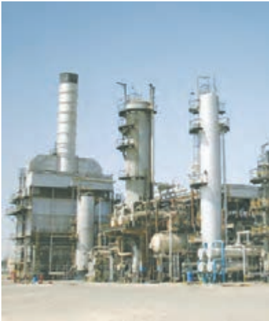
ب) نمای بیرونی برج تقطیر در پالایشگاه
