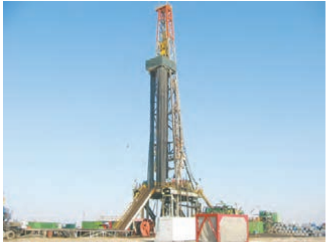
شکل ۱۰- دکل حفاری چاه‌های اکتشافی نفت و گاز
